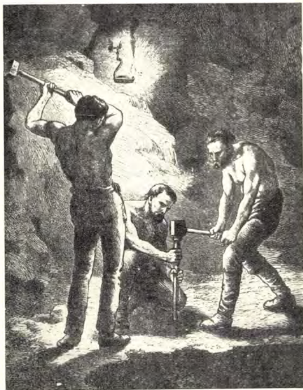
1. „Háromemberes” fúrás keménykőzetben a XIX. század közepén. — N. N. : Návšteva bani. Praha, 1873 című munkából
