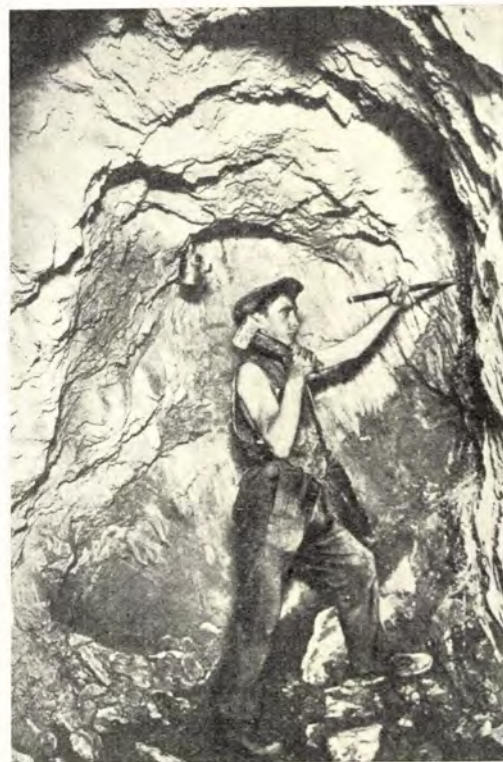
2. Fúróluk készítése ércbányában fúróvésővel a XX. század első felében. — Walther Hein : Erzgebirge című munkájából
